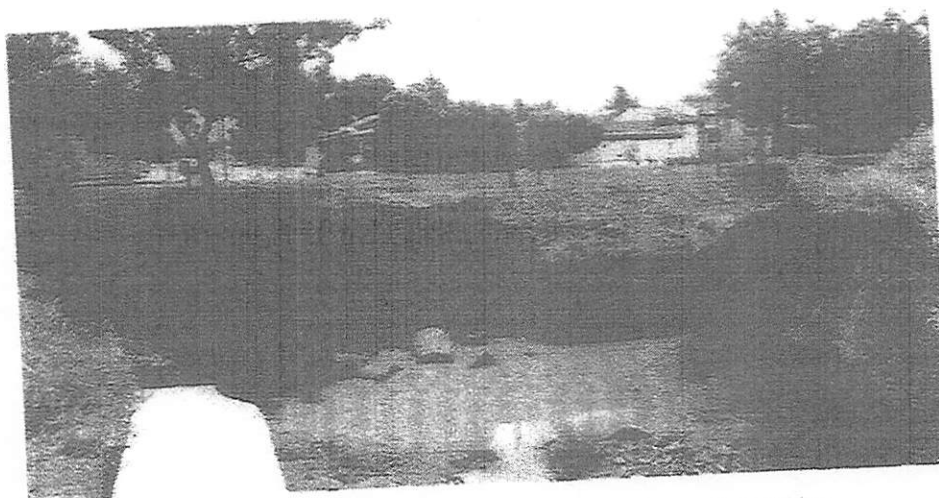
Foto 02 – A erosão descontrolada do canal avança para a infraestrutura pública.
