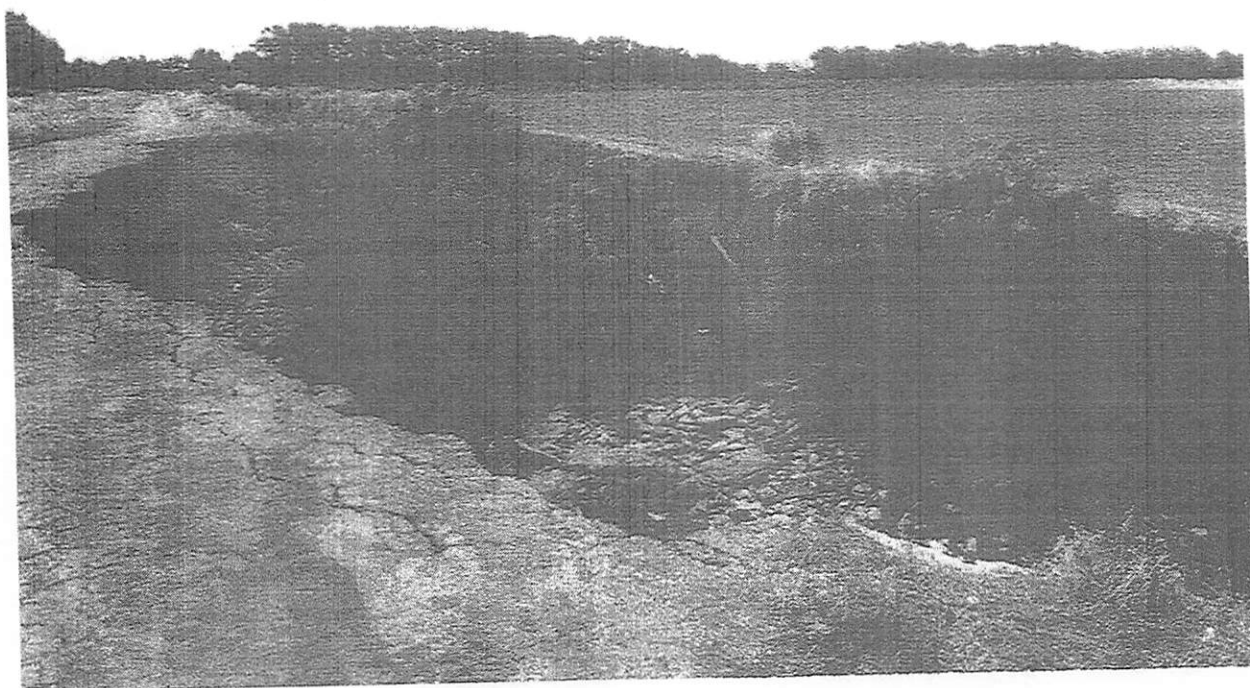
Parte do canal principal onde a erosão já consumiu mais da metade da estrada de acesso Latitude - 13°39'12.40"S - Longitude 57°52'44.59"O
