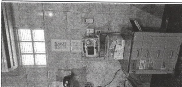
Pronto Atendimento – Bebedouro locado em ambiente e com tubulação de hidráulica e elétrica expostas
