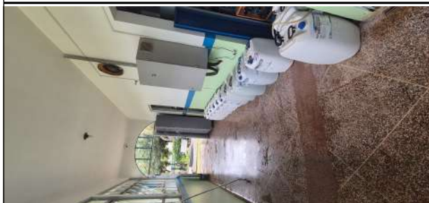
Lavanderia - Área suja - Máquina de lavar com tubulações de Elétrica e hidráulica expostas
