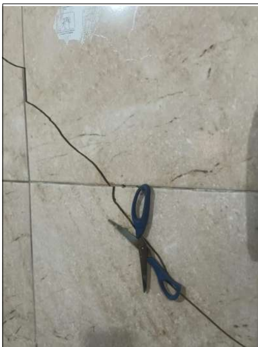
Posto de enfermagem - Presença de rachadura e tesoura necessitando limpeza e desinfecção.
